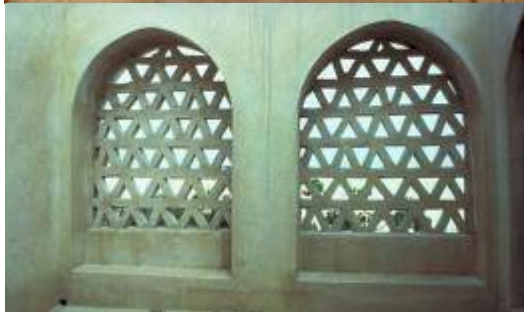
(شكل ١٧) التنوع في التشكيل بالفتحات التي تطل على الفناء وتقل من حدة أشعة الشمس وتسمح بدخول الهواء
