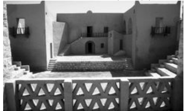
(شكل ١) الفناء كمنظم حراري والانفتاح للداخل
