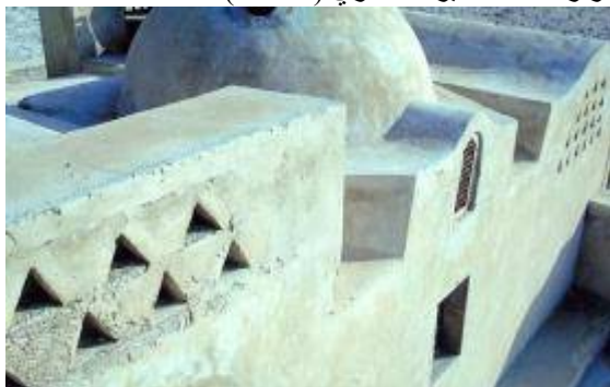
(شكل ٢٥) استخدام الألوان الفاتحة لخفض درجة الحرارة في العمارة الداخلية للمبنى
