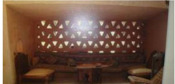
(شكل ١٩) معالجة حسن فتحي للمشربية واستخدامه المخرمات
