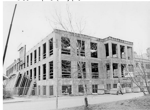
شكل رقم (24) شكل المبنى الإدارى أثناء الإنشاء، وتظهر
