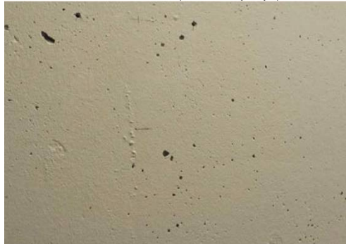
شكل رقم (15) استخدام الخرسانة المدهونة للحوائط .
