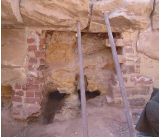
(شكل 10) صورة توضح إستبدال الطوب الأحمر والأسمنت بالحجر والجير. نقلاً عن: Recherché scientifiques: (Ministry of antiquities&centre national French de la Egyptian centre for the study of the temples of karnak(Activity Report2015),p.55
