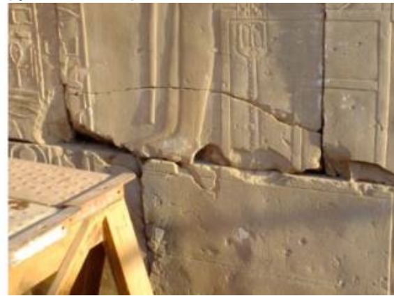
(شكل 11) منظر لشققة حجرية مكسورة من جدارية نحت بارز بالكرنك وتم لصقها بمادة "Araldite" بعد ملا الفجوات بمادة "PLM-M". نقلاً عن: (Ministry of antiquities&centre national de la Egyptian Recherché scientifiques: French-centre for the study of the temples of karnak(Activity Report2015),p.61
