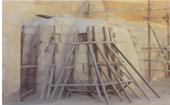
(شكل 7) أعمال إستبدال الأحجار الأثرية بأحجار كبيرة غير مناسبة. نقلاً عن: (زاهى حواس: أهرامات مصر- هضبة الجيزة- أبو الهول ص125).
