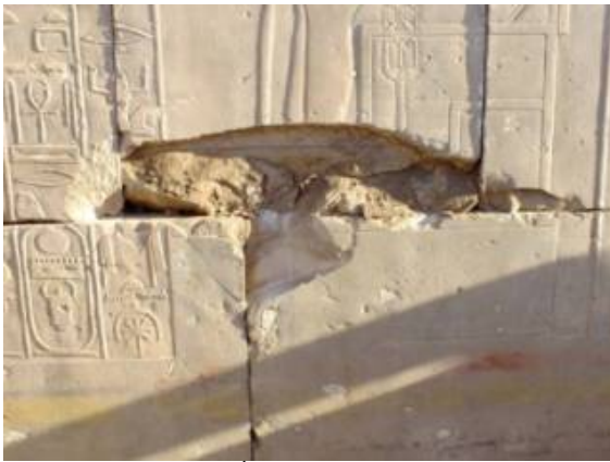
(شكل 11) منظر لشققة حجرية مكسورة من جدارية نحت بارز بالكرنك وتم لصقها بمادة "Araldite" بعد ملا الفجوات بمادة "PLM-M". نقلاً عن: (Ministry of antiquities&centre national de la Egyptian Recherché scientifiques: French-centre for the study of the temples of karnak(Activity Report2015),p.61
