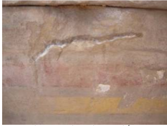
(شكل 12) منظر يوضح ملاً الفراغات والشقوق المتصدعة في الحجر بمادة "PLM-M". نقلًا عن: (Ministry of antiquities & centre national de la Recherche scientifiques: French- Egyptian centre for the study of the temples of karnak (Activity Report 2015), p.62).
