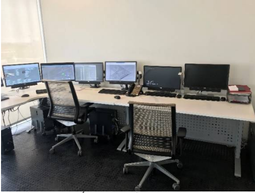
شكل 3: غرفة التشغيل الآلي بالمبنى أ المصدر: الباحثة
