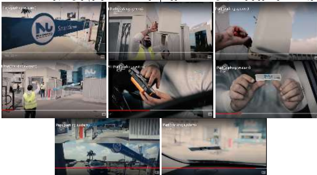
شكل (16) ضبط القارئ على البوابة وتوصيله بالكمبيوتر وبالحاجز وتركيب الشرائح في السيارات
