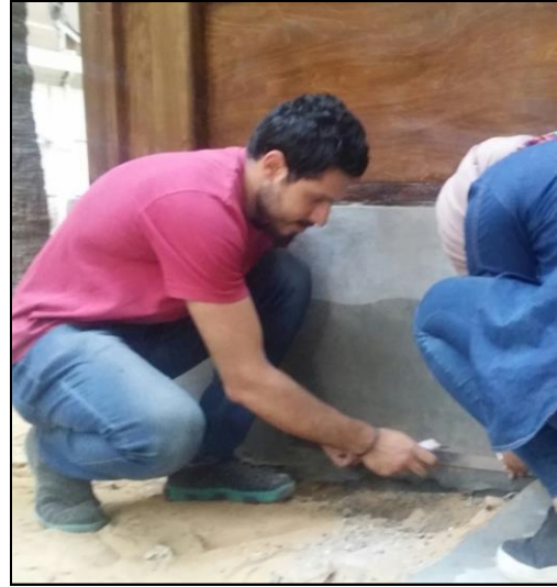
شكل (37) أثناء الحفر لتثبيت الوزرة (السوكلو)
