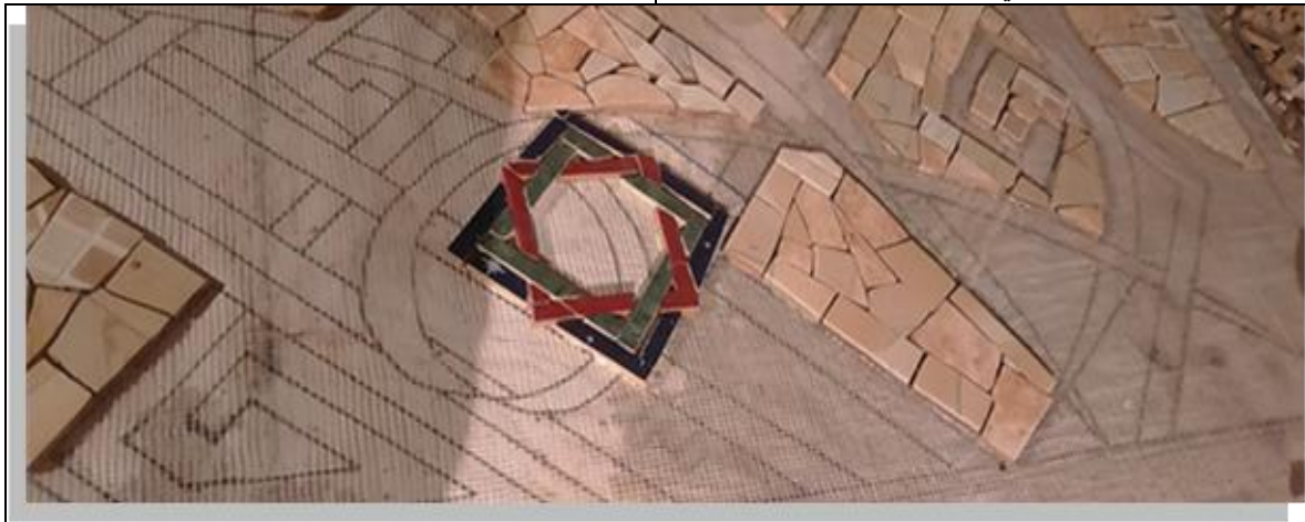
شكل (10) النجمة الإسلامية التي تم تشكيلها بماكينة تقطيع السيراميك
