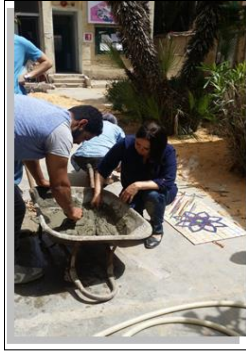
شكل (41) يوضح عملية اضافة الماء وعجن المونة
