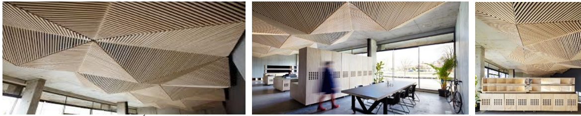
شكل (22) يوضح السقف الذي يتكون من طيات خشبية مثلثة الشكل تشبه الأوريغامي.
