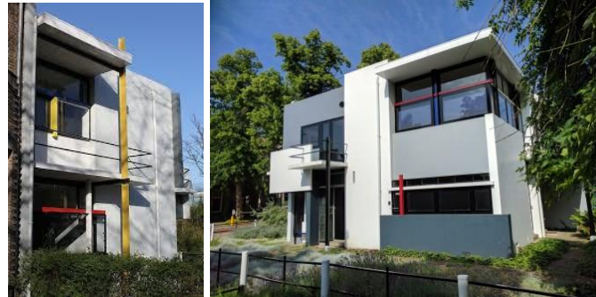
صور (17) توضح تصميم الكتلة الخارجية لمنزل ريتفيلد شرويدر - هولندا للمعماري غيريت ريتفيلد والتي اعتمدت على الخطوط العمودية والرأسية والأفقية الواضحة واستخدام ألوان لوحات موندريان
