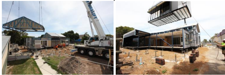
صورة (6) صور توضح أثناء نقل وتركيب فراغات المدرسة في الموقع
