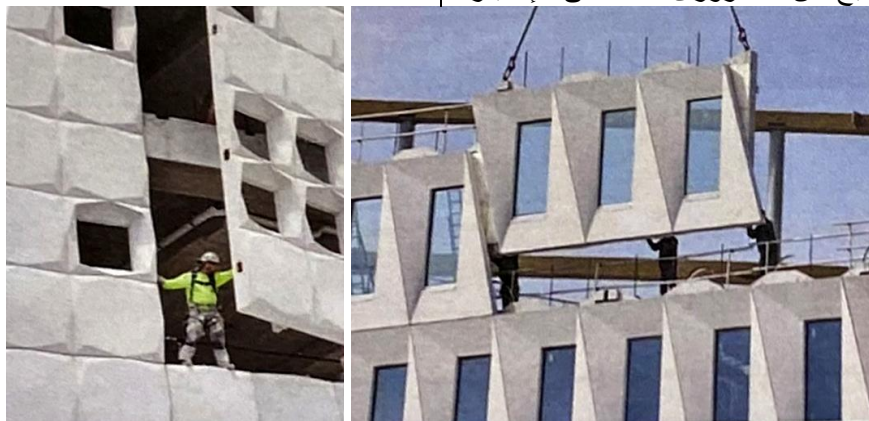
صورة (3) توضح مجموعة من عناصر سبق التجهيز المستخدمة في أعمال النهو والتشطيب
