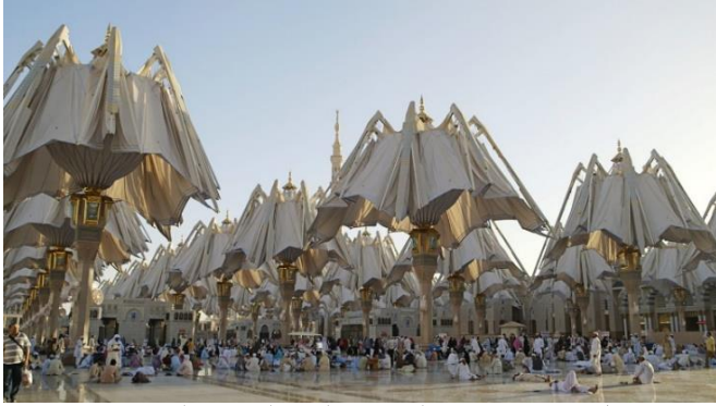
شكل (5-ب) يوضح المظلات المتحولة في حالة الإغلاق
