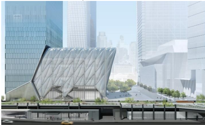
شكل (4ب) يوضح المبنى وهيكله الخارجى في حالة تقلص وإنكماش. https://www.architecturaldigest.com/story/shed-hudson-yards
