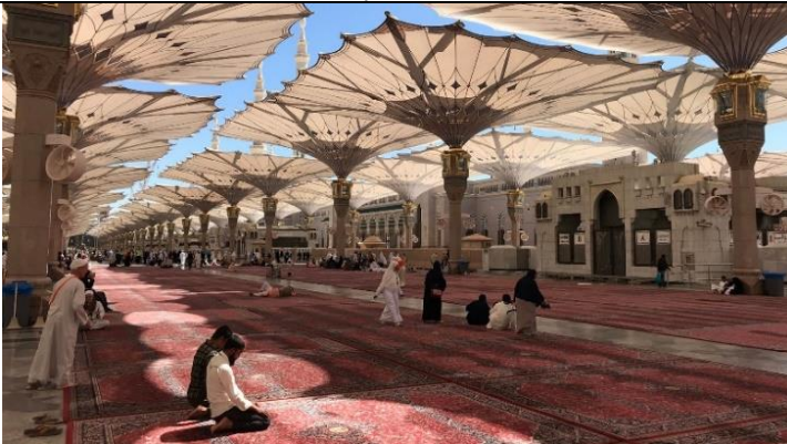
شكل (5أ) يوضح إستخدام المظلات المتحولة في المسجد النبوى بالمدينة Madinah Piazza Shading Project - SL Rasch (sl-rasch.com)
