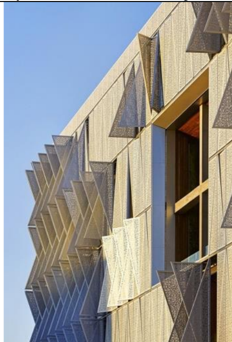
شكل (2-ج) يوضح تأثير الواجهة المتحركة على إضاءة الحيزات الداخلية
