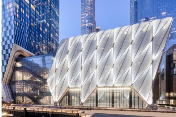
شكل (4أ) يوضح المبنى وهيكله الخارجى في حالة تمديد لإضافة حيزات أخرى للإستخدام.
