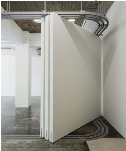
شكل (7-ب) يوضح الحوائط المتحركة تبعاً لمسار محدد بالإنزلاق والطي. /https://www.pinterest.com/pin/756745543662046192
