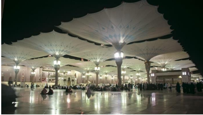
شكل (5-ج) يوضح المظلات المتحولة في حالة الفتح
