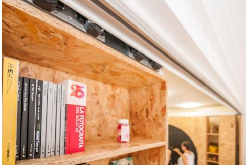
شكل (6-د) يوضح القضبان التي تتحكم في حركة الوحدات
