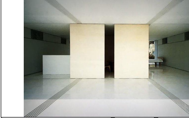
شكل (7-أ) يوضح المجارى بالأرض والسقف لتحرك الحوائط وتعطى عددا كبيرا من التحول فى الحيزات
