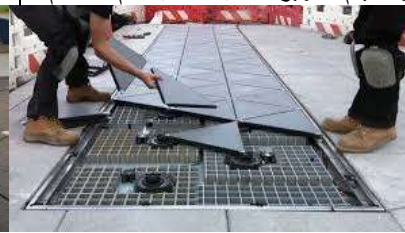
صورة 21، 22 توضحان الأرضيات الانضغاطية قبل وبعد التركيب
