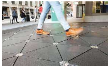
صورة 21، 22 توضحان الأرضيات الانضغاطية قبل وبعد التركيب
