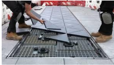
صورة 21، 22 توضحان الأرضيات الكهروضغطية قبل وبعد التركيب
