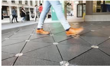
صورة 21، 22 توضحان الأرضيات الكهروضغطية قبل وبعد التركيب
