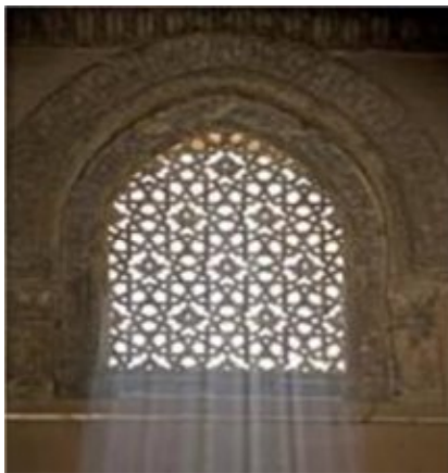
شكل ٢٣ المخمرات الجصية بمسجد ابن طولون بالقاهرة وتشتيت الضوء وتجزئته ودخوله في صورة حزم ضوئية تشكيلية
