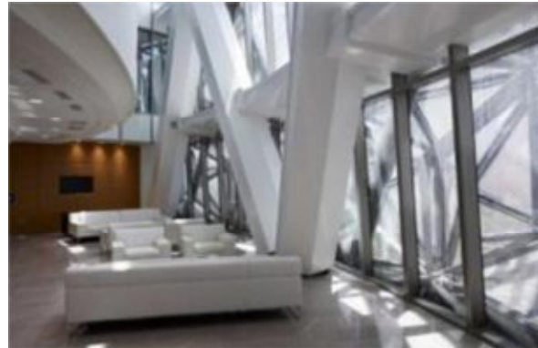
شكل ٤٥ الفراغ الداخلي للمبنى والمكيفة ميكانيكيا واستخدام المخمرات كغلاف خارجي للتظليل وتوليد طاقة كهربية من اشعة الشمس من خلال الالياف الزجاجية للغلاف
