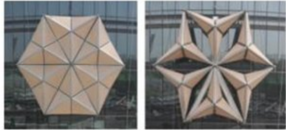
شكل (٤٣)، (٤٤)، (٤٥) تشكيلات النسيج الخارجي تفتح وتغلق طبقا لحركة الشمس وشدة الضوء على مدار اليوم الواحد
