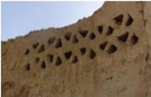
شكل ٧ المخمرات المثلثة الشكل كفتحات للتهوية ودخول الضوء بأحد الجدران من الطوب اللين بالبيوت النوبية
