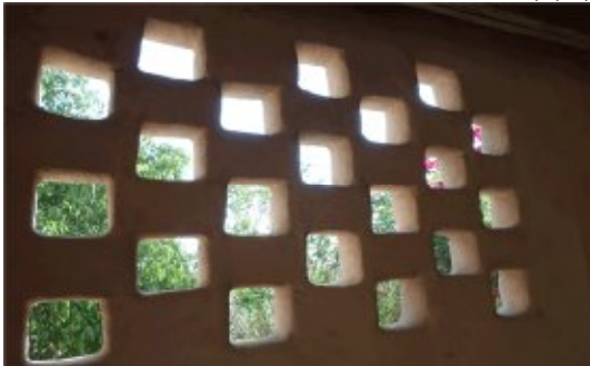
شكل ٦ المخمرات مربعة الشكل كفتحات للتهوية ودخول الضوء بأحد الجدران من الطوب اللين بالبيوت الريفية
