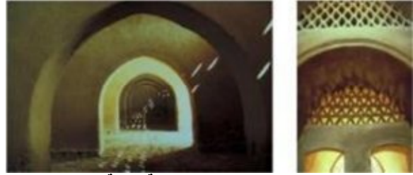
شكل ٣٢ المخمرات بداخل احد البيوت بقرية القرنة للمعماري حسن فتحي وحركة الضوء من خلالها اثناء النهار راسمة أشكالا بديعة في أوقات معينة بداخل الفراغ وكأنها ساعة ضوئية للمكان
