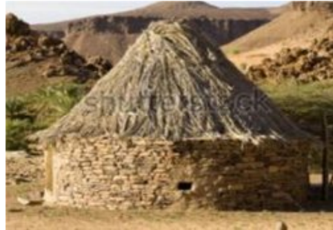
شكل ١ المخمرات كفتحات في الحوائط الحجرية بغرض المنفعة لدخول الهواء والضوء بالاكواخ الافريقية البدائية بمالى .
