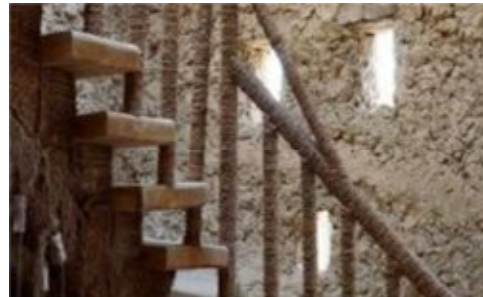
شكل ٣ المخمرات كفتحات بغرض المنفعة في الحوائط من القرشيف لدخول الهواء والضوء بأحد البيوت بواحة سيوة
