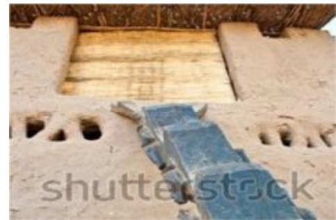
شكل ٢ المخمرات كفتحات في الحوائط الطينية بغرض المنفعة لدخول الهواء والضوء بالبيوت الافريقية البدائية بمالى .
