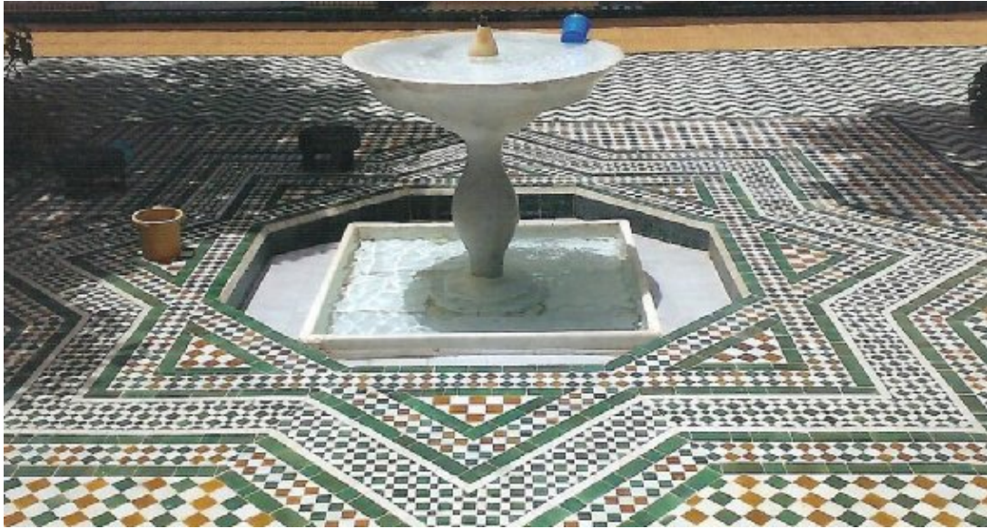
شكل (٢١) تجميل معماري، أرضية مزخرفة بزخارف على هيئة الطبق النجمي البسيط، بلاطات خزفية مزججة "الزليج"، مكناس، المغرب.
