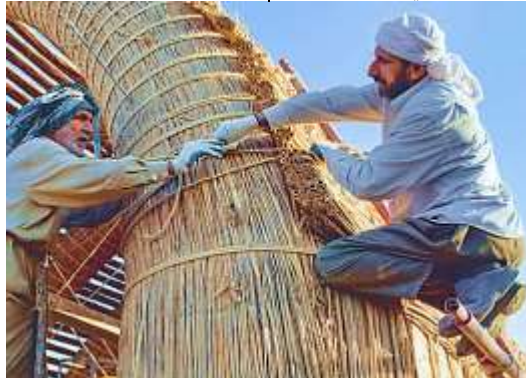
صورة (10) توضح التكنولوجيا البسيطة في تشكيل مبنى (المضيف) يدوياً (Watson, 2019, p. 297)
