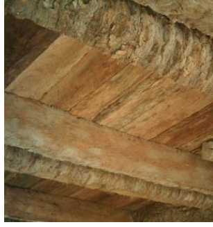
(شكل ٧ ب) المنظر الداخلي للسقف من شجر النخيل بعد الإغلاق. (١٩)
