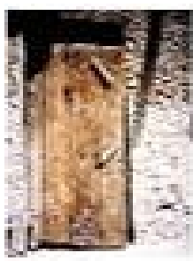
(شكل ٥) باب تقليدى من خشب النخيل والزيتون المعاد تدويره.
