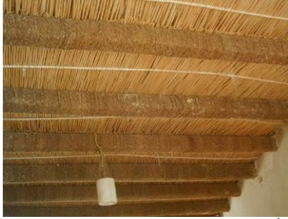
(شكل ١٥ أ) استخدام سيقان شجر النخيل في الى المدخل حيث الاسقف يساعد تقليل الحرارة في الداخل.
