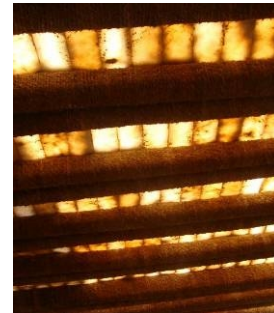
(شكل ١٩) اضاءه وتدفعه الداخل باشعه الشمس، المتخلله لكتل الرمل الابيض فى السقف. (١٩)
