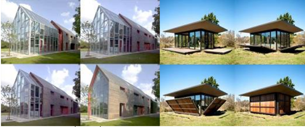
الشكل (7) صور الحوائط تتحرك سواء في الاتجاه الأفقي والرأسي
