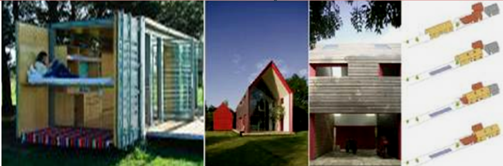
شكل (5) زيادة المساحة الداخلية عن طريق حركة جزء من المبني ، انزلاق المبني وتحركه بأكمله
