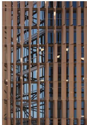
شكل (2) يوضح واجهة مبنى جامعة ولاية أريزونا التي تتكون من كاسرات شمس متحركة (Ferello, 2018)
