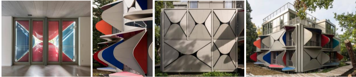
شكل (12) يوضح واجهة مبنى Ballet Mécanique وهي بتكون من كاسرات شمس متحركة ملونة وصورة للفراغ الداخلي عند غلق الفتحات (Ravenscroft, 2018)
