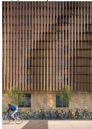
شكل (2) يوضح واجهة مبنى جامعة ولاية أريزونا التي تتكون من كاسرات شمس متحركة (Ferello, 2018)
