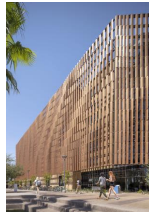
شكل (2) يوضح واجهة مبنى جامعة ولاية أريزونا التي تتكون من كاسرات شمس متحركة (Ferello, 2018)
